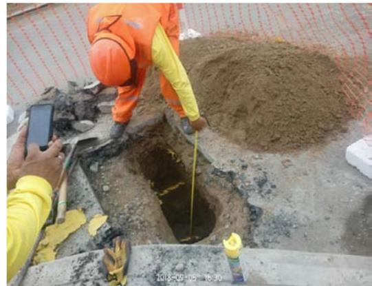
**Figura 1.** Construcción, demolición y excavación de zanjas [8]
